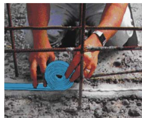
3) ...затем резиновый профиль вдавливается в клеящий состав.
